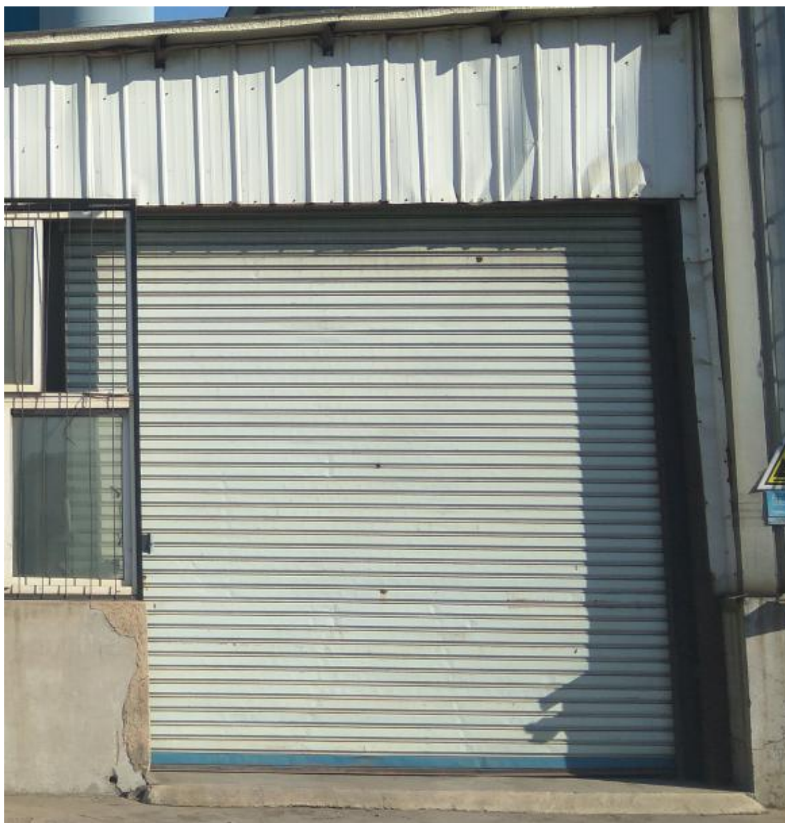
依托危废暂存间
