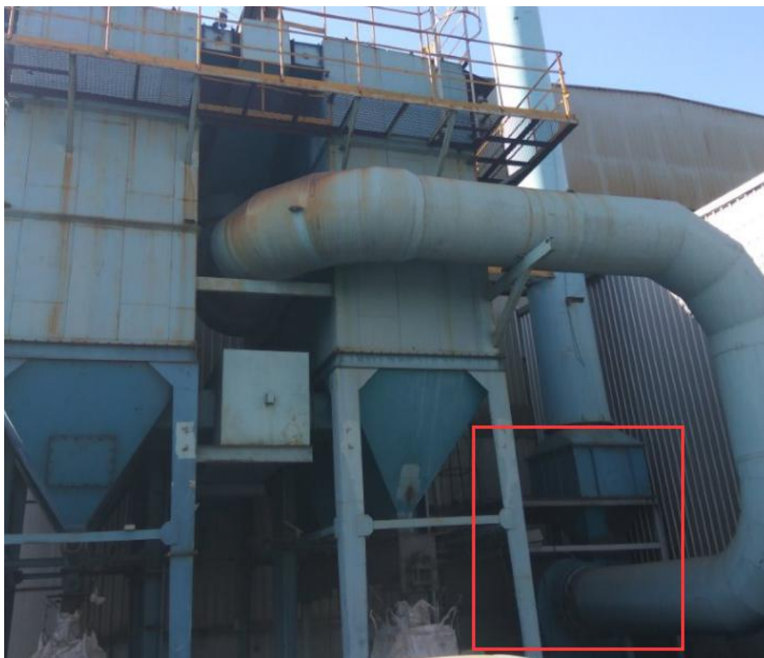
风机隔声罩、管道消声器
