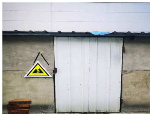
危险废物暂存间
