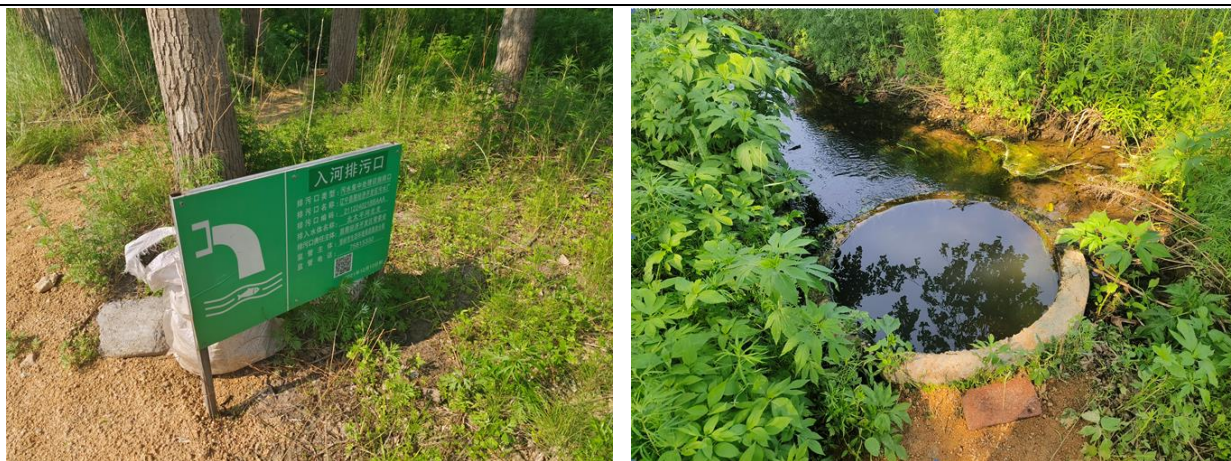
图 3-7 本项目尾水排口
